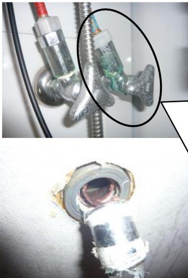
みなさんのお宅にもこのような物がトイレ・洗面台・キッチンに付いてます。これはアンクル形止水栓というものです。給水管・給湯管と水栓器具を接続する部品です。画像を見てもらえるとわかると思いますが錆が出て水漏れもあります。この部品の交換修理が多いのですが・・・まわした途端にボキッ!! 水道管の中に残ったネジ部は専用工具がないと外せません。このようなことになる確率がかなり高いです。止水栓を回すときは必ず元バルブ、地下水のお宅はポンプの電源を抜いて水圧が無くなってから作業をします。怪しいなと思ったら早めの取替えをお勧めします。
