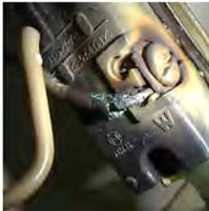
**<埋め込みコンセント火災>** コンセントの周囲から火災が発生する事例は「トラッキング火災」、「たこ足配線火災」、「配線コード火災」だけではありません。内壁に埋め込まれているコンセント内部でも、火災が発生する可能性があります。これは設置されている場所によっても違いはありますが、特に台所・洗面所・トイレなど、湿気の多い場所で使用しているコンセントは、屋内配線とコンセント・スイッチの接続部でトラッキング現象による火災が発生しています。また、コンセントを設置してから長時間経過したものは、表面だけでなくボックス内部に結露が発生したり構成部分が劣化することにより火災が発生した場合がありますので、電気業者に点検を依頼するなど定期的な検査を行って、火災の発生を防ぎましょう。
